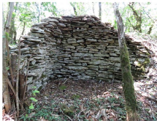
Grand coupe-vent "en creux de main" (n° 12) et petit coupe-vent "en fer à cheval" (n° 78), Les Riceys.
