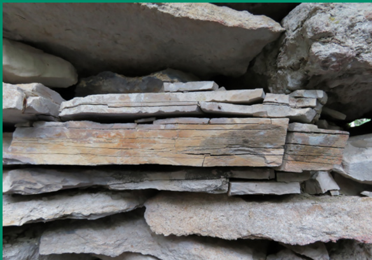
Cadole n° 96 à Courteron, exemple de pierre délitée
