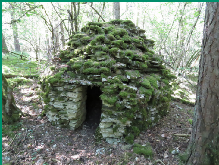
Cadole n° 22 à Gyé-sur-Seine, cas de cadole sans élément de contrebutement
