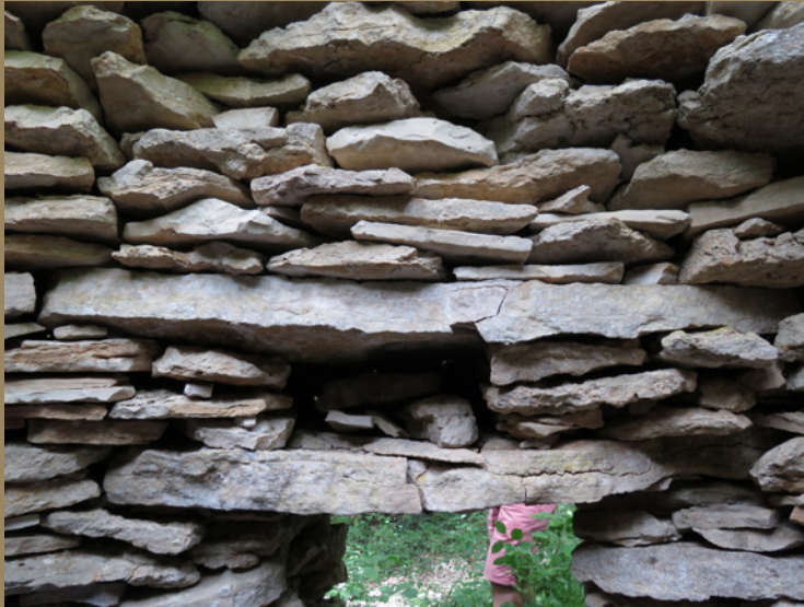
Construction en pierre sèche (détail de la cadole n°96, Courteron)
