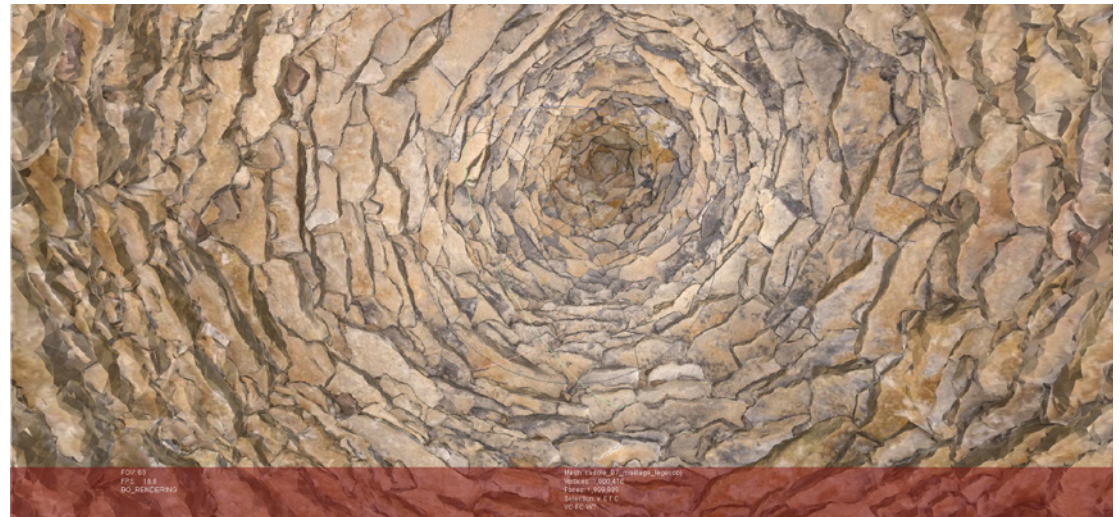
Voûte en encorbellement de la cadole B7 (n°56) ; relevé 3D, CNRS-Archeovision, P. Mora.
