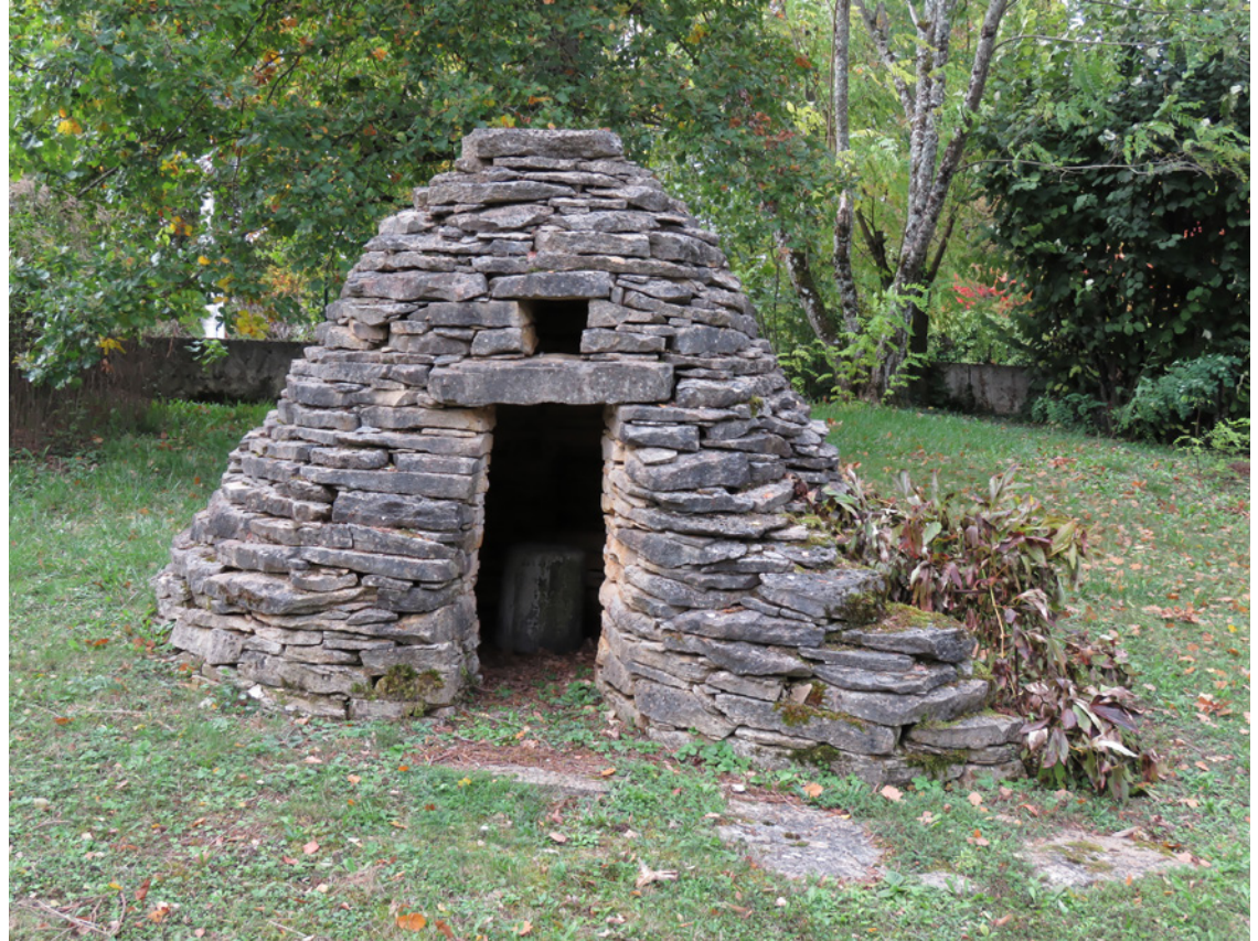
Cadole n° 164 à Les Riceys, exemple de néo-cadole. Elle reprend le principe constructif des cadoles locales en pierre sèche
