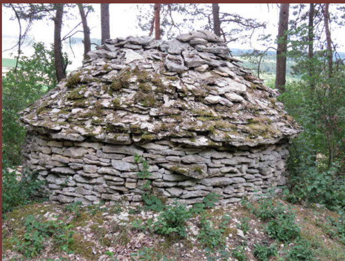
Exemple de débord de toiture : cadole n° 98 à Gyé-sur-Seine (proche Courteron)
