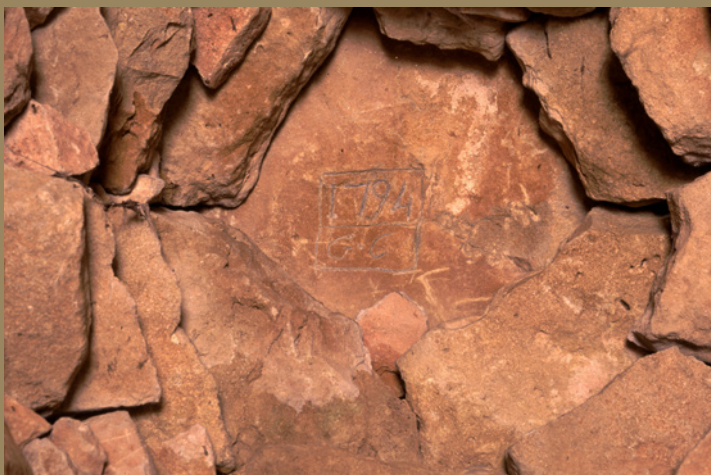
Dalle terminale de la voûte d'une cabane en pierre sèche à Blauzac, Gard (France) : dans un cartouche, le propriétaire-constructeur a gravé la date d'achèvement (1794) et les initiales de son nom (G.C).
