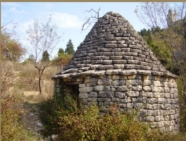
Cabane en pierre sèche, du type appelé localement «cabanon pointu», à Reillanne (Alpes-de-Haute-Provence), XIX e siècle, Photo Jean Laffitte (CERAV).
