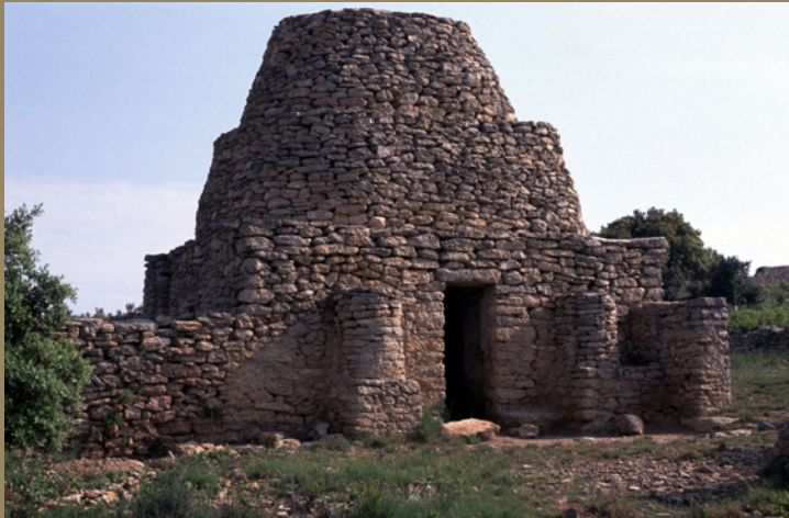
Cabane en pierre sèche à degrés à Salon-de-Provence (Bouches-du-Rhône), XIXe siècle. Photo Dominique Repérant (CERAV).
